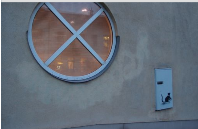
Okno v objektu pod FI na ulici Hrnčířské
